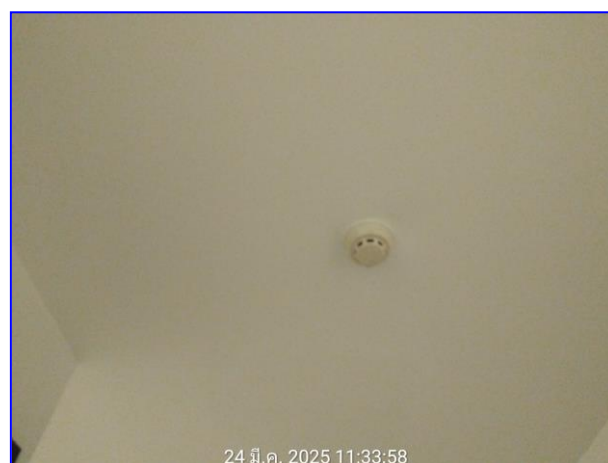
รูปที่ 2.16 เครื่องดักจับควัน
